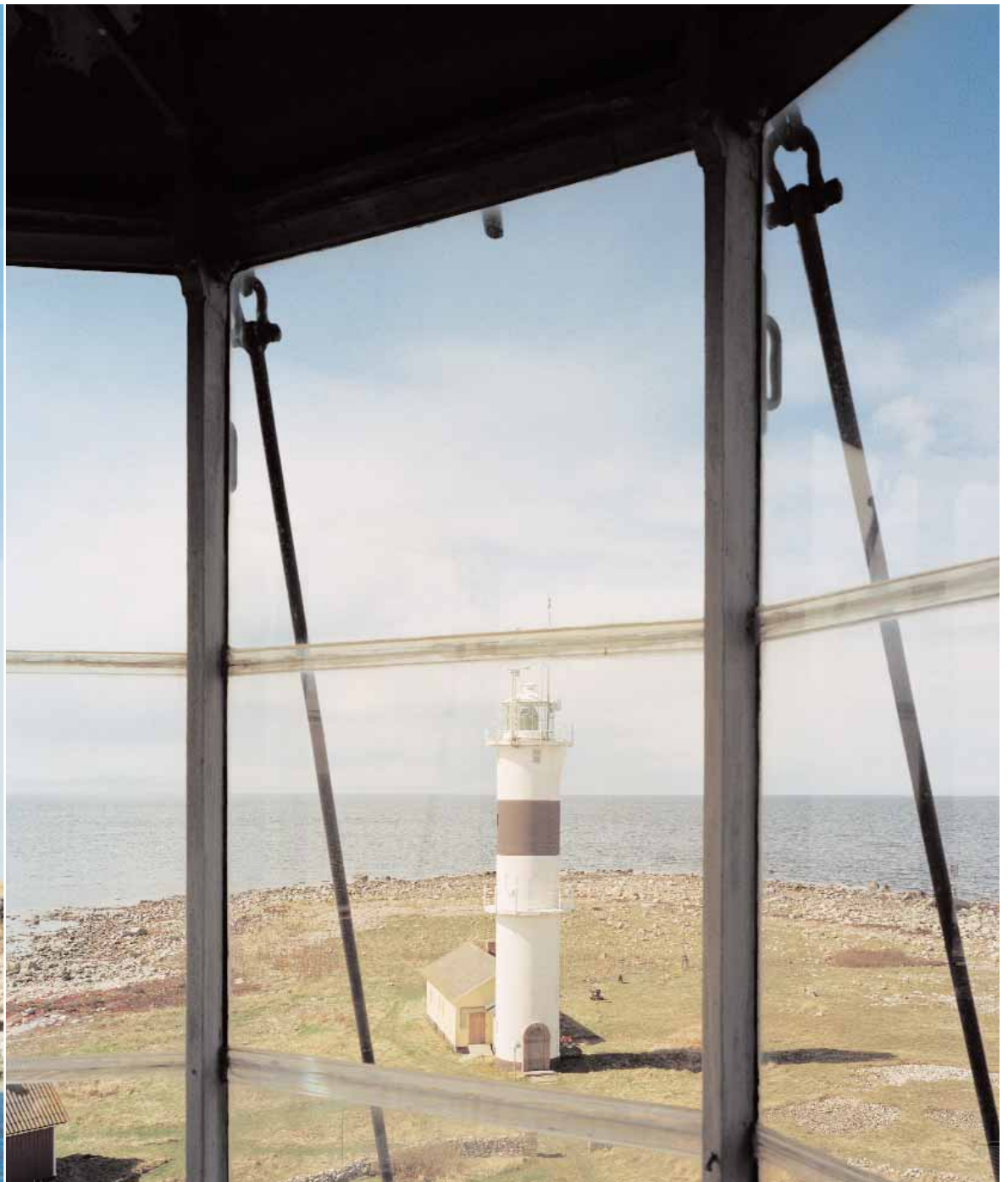
Fyrtornet väster om de gamla dubbeltornen uppfördes 1945 och är byggt i armerad betong.
